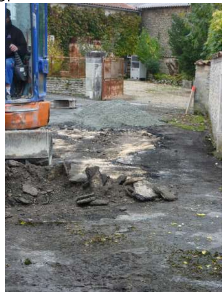
RUE DE CHEZ BOISFERONS EN TRAVAUX
